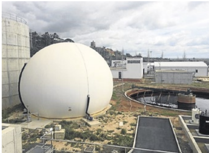
Biofiltración. La nueva depuradora de La Antilla emplea esta tecnología.
