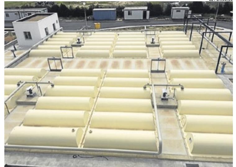
Instalaciones. La depuradora amplía unas instalaciones anteriores.
